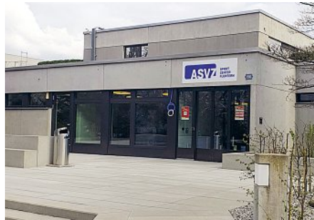
Der Haupteingang des ASVZ Fluntern.
